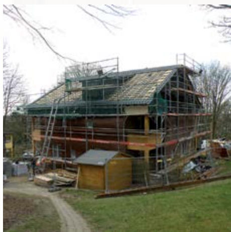
Haus 3 während der Bauphase
