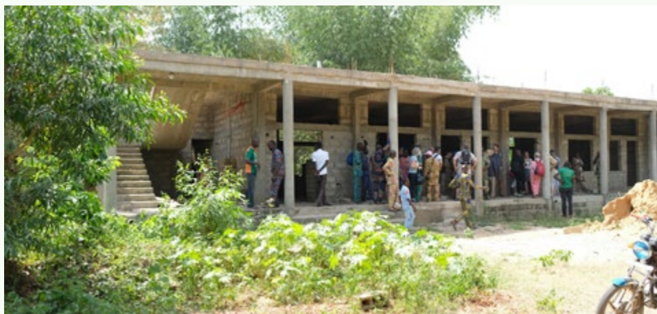
Der Rohbau der Schule auf der Insel Gbeko
